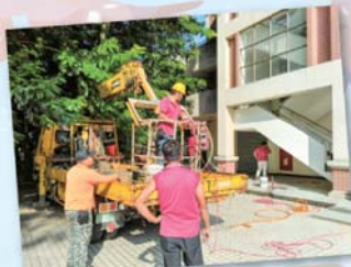
體育館屋頂漏水改善
